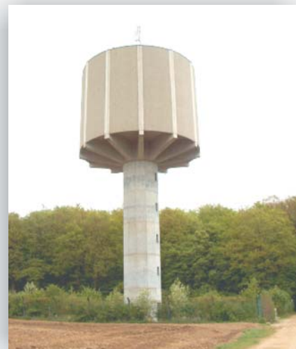
Wasserturm in Luxemburg
